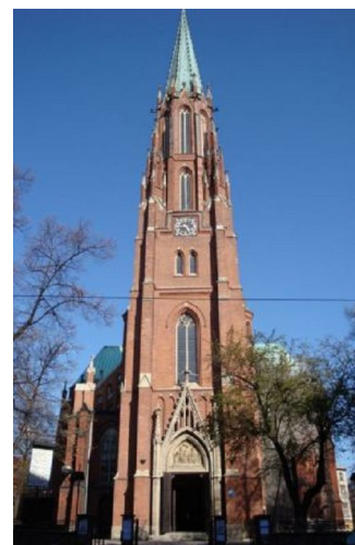
Fot. nr 37: Zabytkowy kościół św. Trójcy
