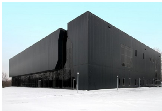
Fot. nr 13: Hala sportowa przy ul. Modrzewskiego
