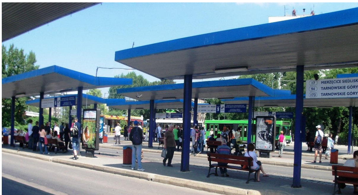
Rysunek 3 Wiaty przystankowe na Dworcu autobusowym w Bytomiu
