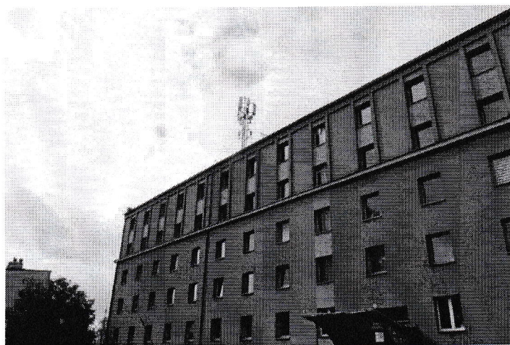
Zał. nr 1: Widok ogólny instalacji radiokomunikacyjnej.
