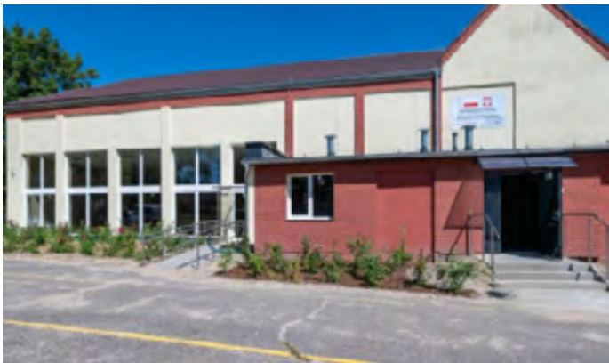
Zdjęcie 31: Budynek przy ul. Stolarzowickiej 19 w Bytomiu po remoncie
