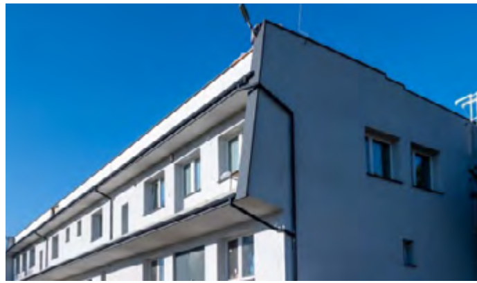
Zdjęcie 32: Budynek przy ul. Worpie 18 w Bytomiu po remoncie
