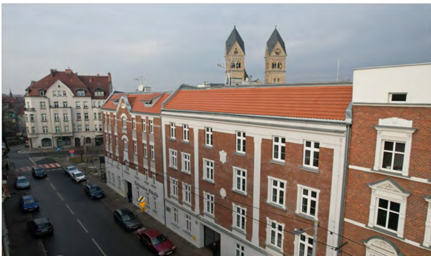
Zdjęcie 26: Wyremontowane kamienice przy ul. Musialika 1 i 3 w Rozbarku
