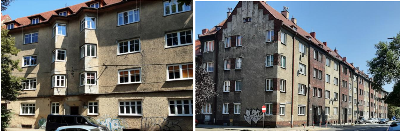
Zabudowa blokowa na ulicach Woźniaka i Strzelców Bytomskich (arch. PDZ ALMA)
