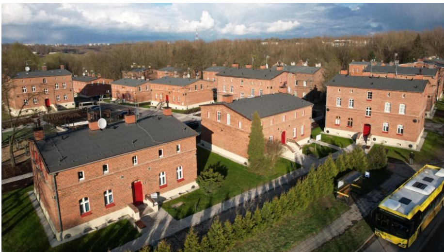
Kolonia Zgorzelec po rewitalizacji - 2024 r. ( https://www.bytom.pl/aktualnosci/ )
