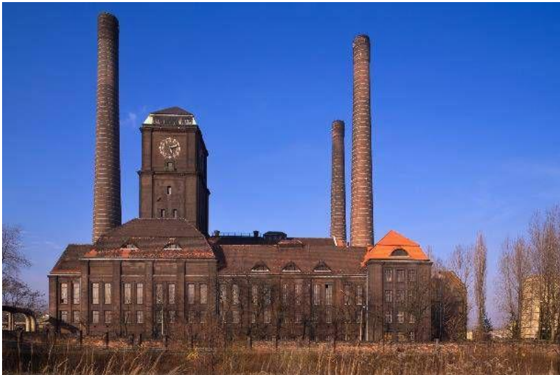
Elektrociepłownia Szombierki ( www.dziennikzachodni.pl/bytom-zabytkowa-hala-elektrocieplowni-szombierki-ma-sluzyc-kulturze/ar/c3-475852 )
