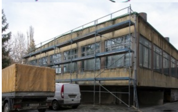
Ruszył remont budynku Rady Miejskiej w Bytomiu (1)
