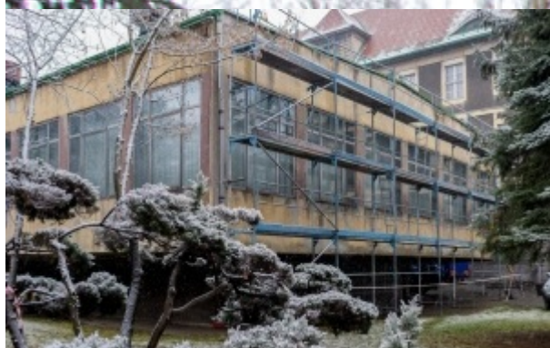
Ruszył remont budynku Rady Miejskiej w Bytomiu
