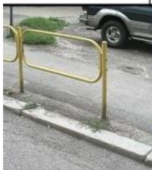
w - przed remontem
