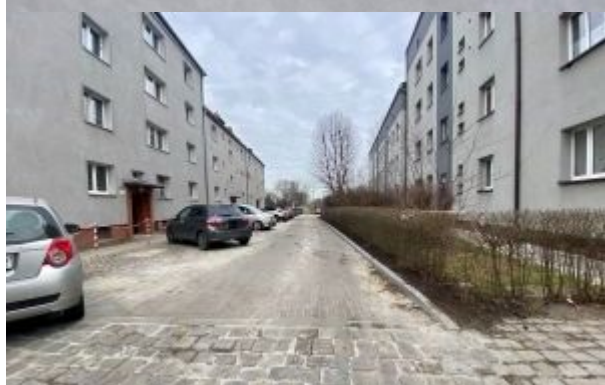
Przebudowa ulicy bocznej Woźniaka zakończona (1)
