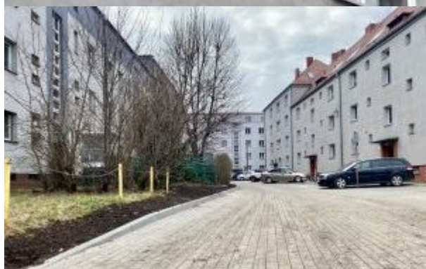
Przebudowa ulicy bocznej Woźniaka zakończona
